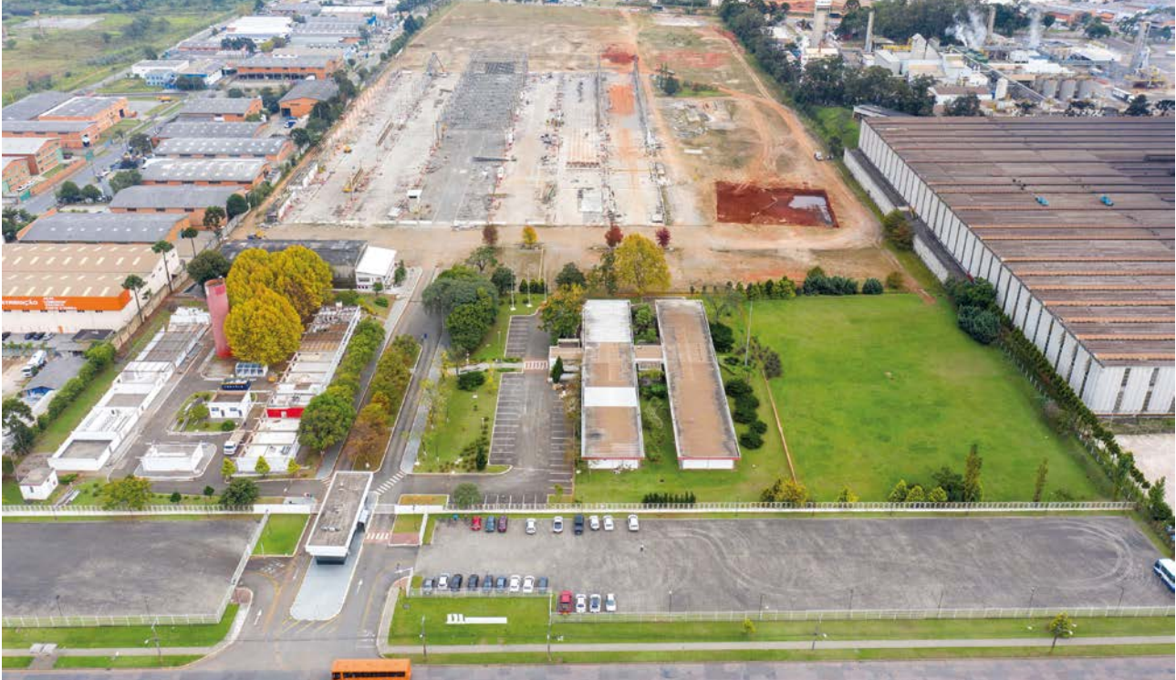
HORSCH do Brasil Ltda., eine Luftaufnahme des Standorts in Curitiba, Brasilien. Hier entsteht das neue Werk.
