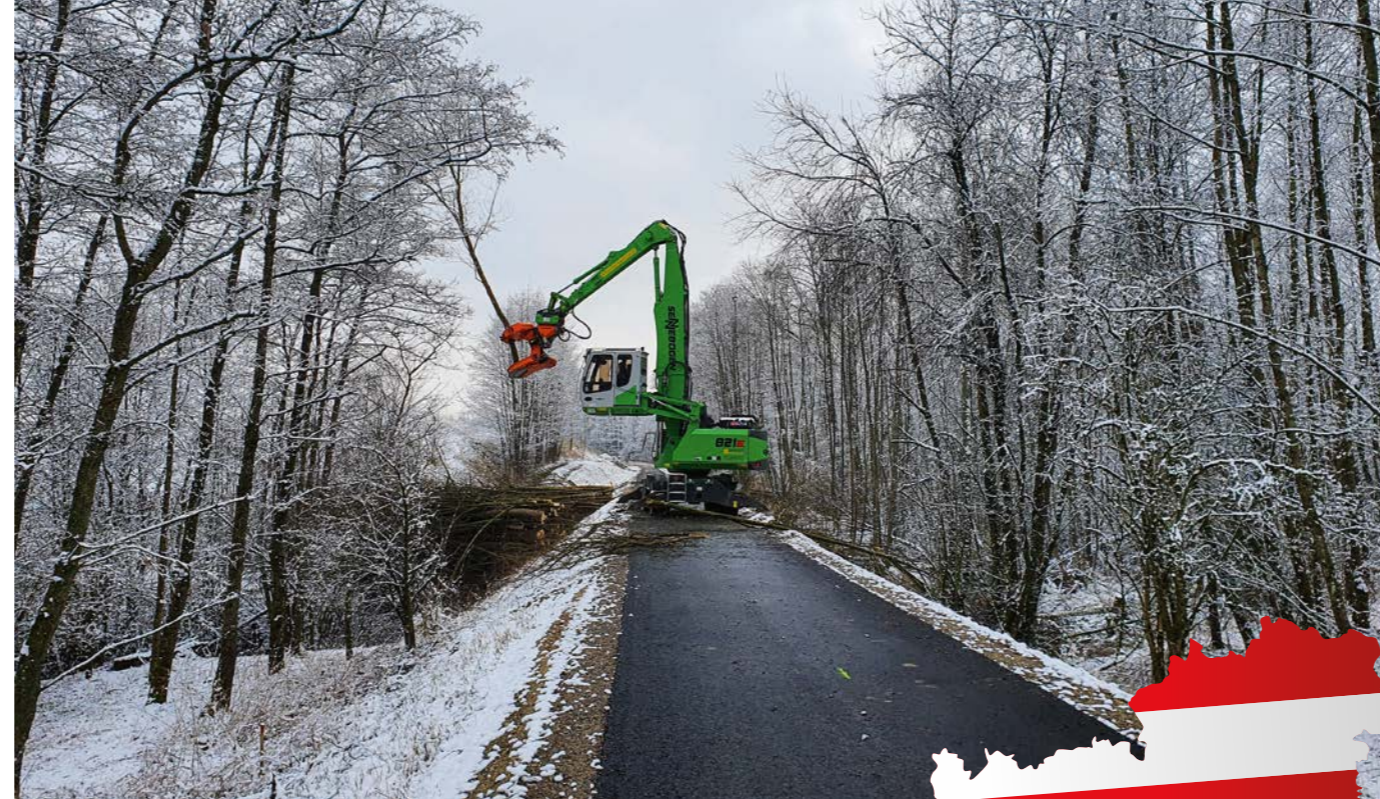
Mit dem drehbaren Teleskop-lader werden Baumpflegearbeiten erledigt.
