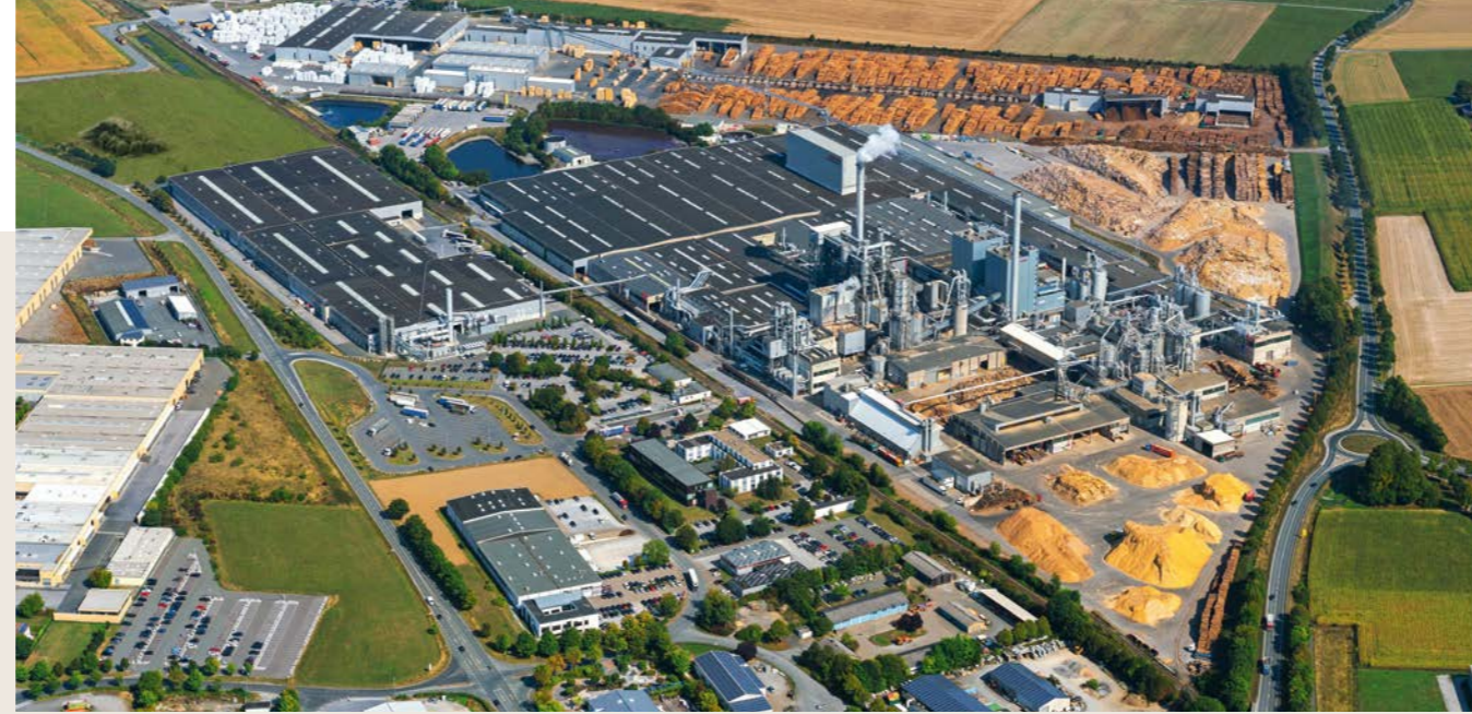
Der Standort Brilon ist ein vollintegriertes Werk. Das erlaubt die Nutzung zahlreicher Synergien.
