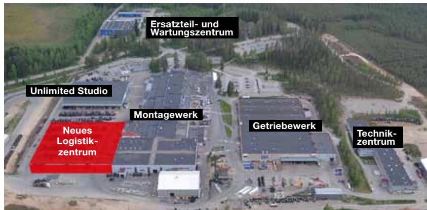
Das neue 8.000 m 2 große Logistikzentrum entsteht im Bereich zwischen dem Montagewerk und dem Unlimited Studio.
